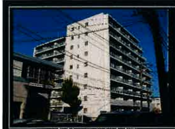
建物西側外観
