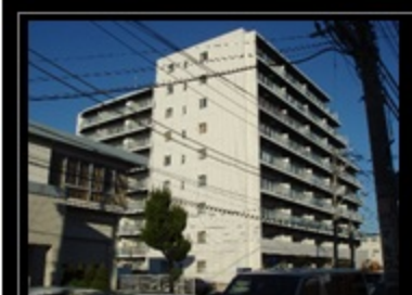
建物西側外観
